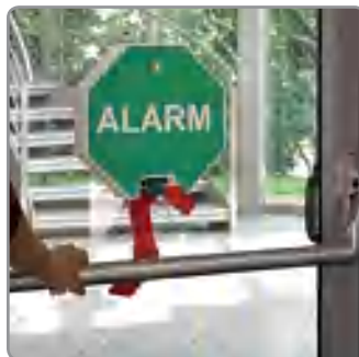
Alarm - resetten met sleutel
